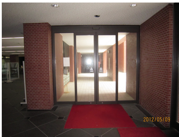
【データ7-4】人間社会第1講義棟自動ドア取設・スロープ取設
