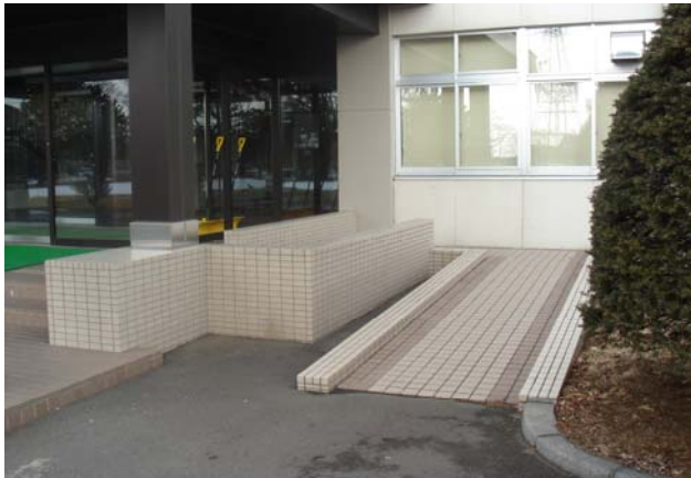
【学生玄関前スロープ】
