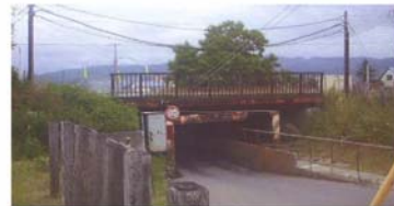
図1 施工前の銀河通
