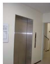
専攻科棟エレベータ
