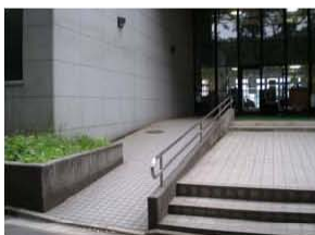
図書館棟入口スロープ
