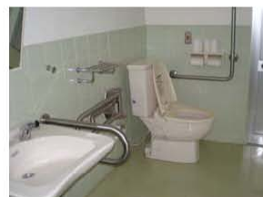
5棟 身障者用トイレ
