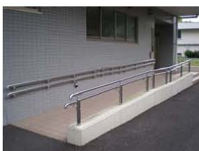
専攻科棟入口スロープ
