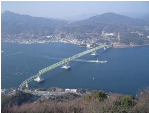
大島大橋(長さ 1020メートル)
