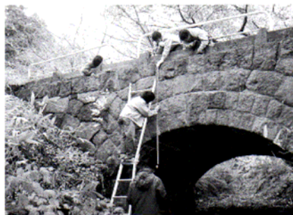
アーチ橋石積みの現地計測
