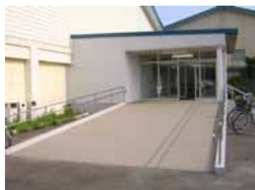
体育館玄関前スロープ
