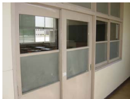
資料9-1-①-2 透明ガラスとなった教室
