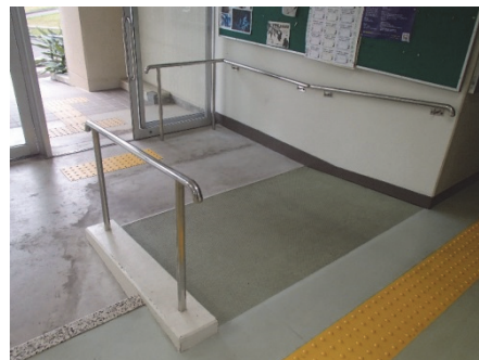
図2 共通教育棟3号館1階出入口スロープ
