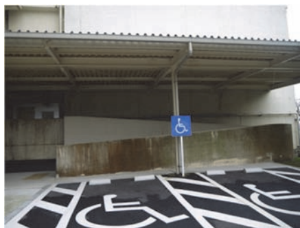
図1 共通教育等障害者用駐車場の整備
