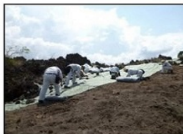
シート敷設の様子
