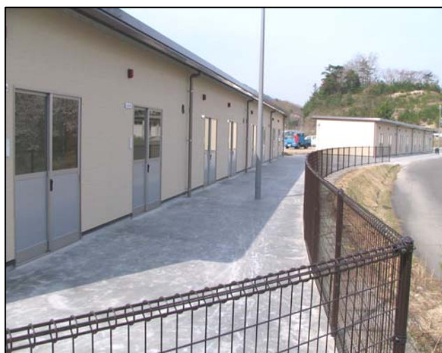
新設された部室棟
