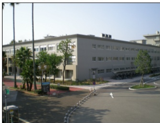
北東面外観(改修後)
