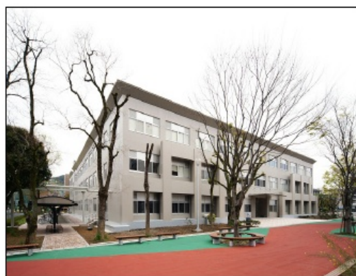
南東面外観(改修後)
