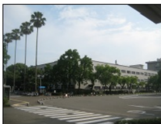
北東面外観(改修前)
