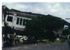
2006年5月26日インドネシアジャワ島中部地震によるRC2階建てオフィスの被害 (撮影: 前田匡樹氏, 東北大学)
