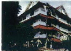
2006年5月26日インドネシアジャワ島中部地震によるRC4階建てオフィスビルの被害 (撮影: 前田匡樹氏, 東北大学)
