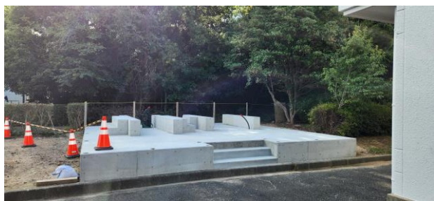
発電機基礎工事の状況
