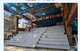
建設中の様子
