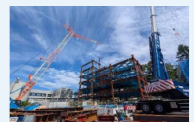
建設中の様子
