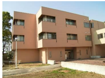
図書・ネットワークセンター棟
