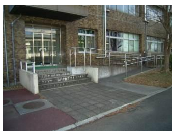
スロープ (第2研究棟)
