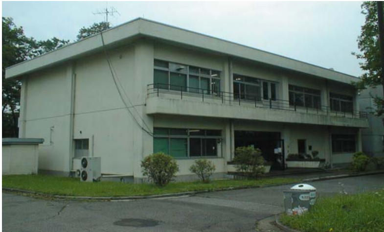
共同センター本館正面写真
